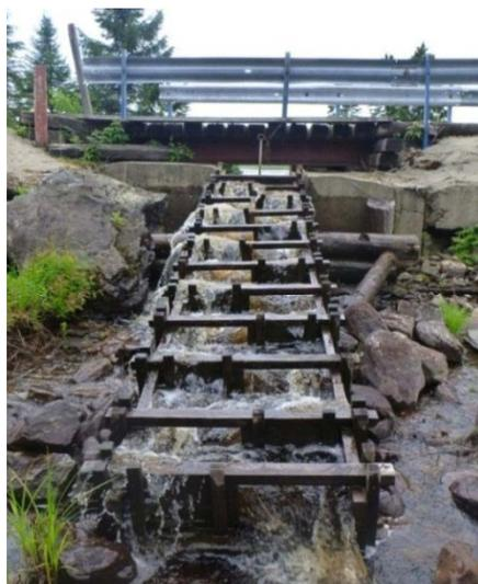
Photo 5. Échelle à poisson aménagée sur le barrage du Bras de la rivière Ouelle
