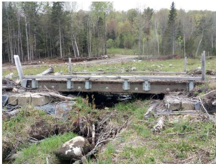
*Figure 17. Ouvrage amovible constitué de poutres de bois interreliées (matelas-culées) (tirée de Ferland, 2022)*
