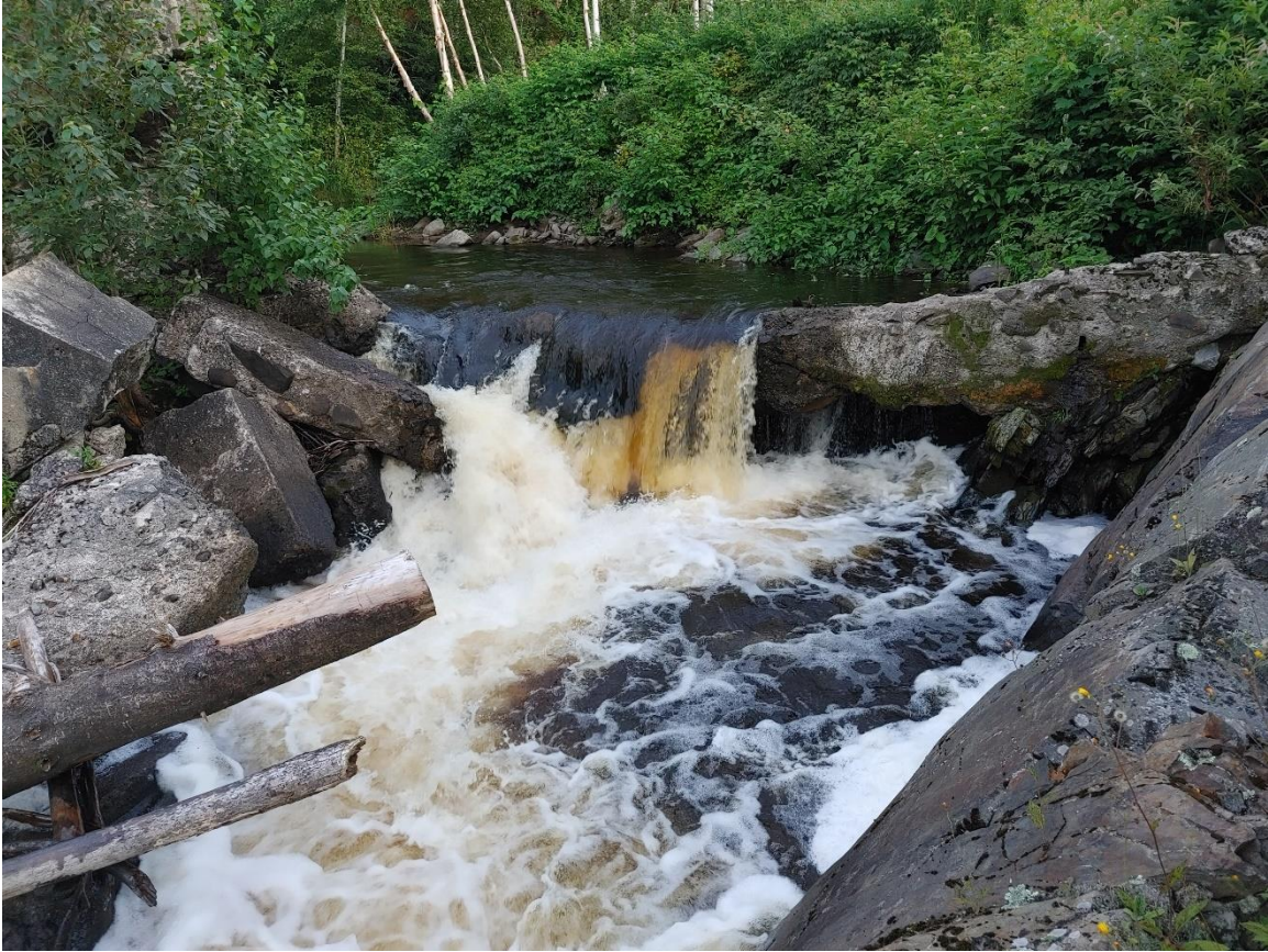
Figure 7. Vue du barrage X0000650 sur la rivière Cacouna (OBAKIR, 2023)
